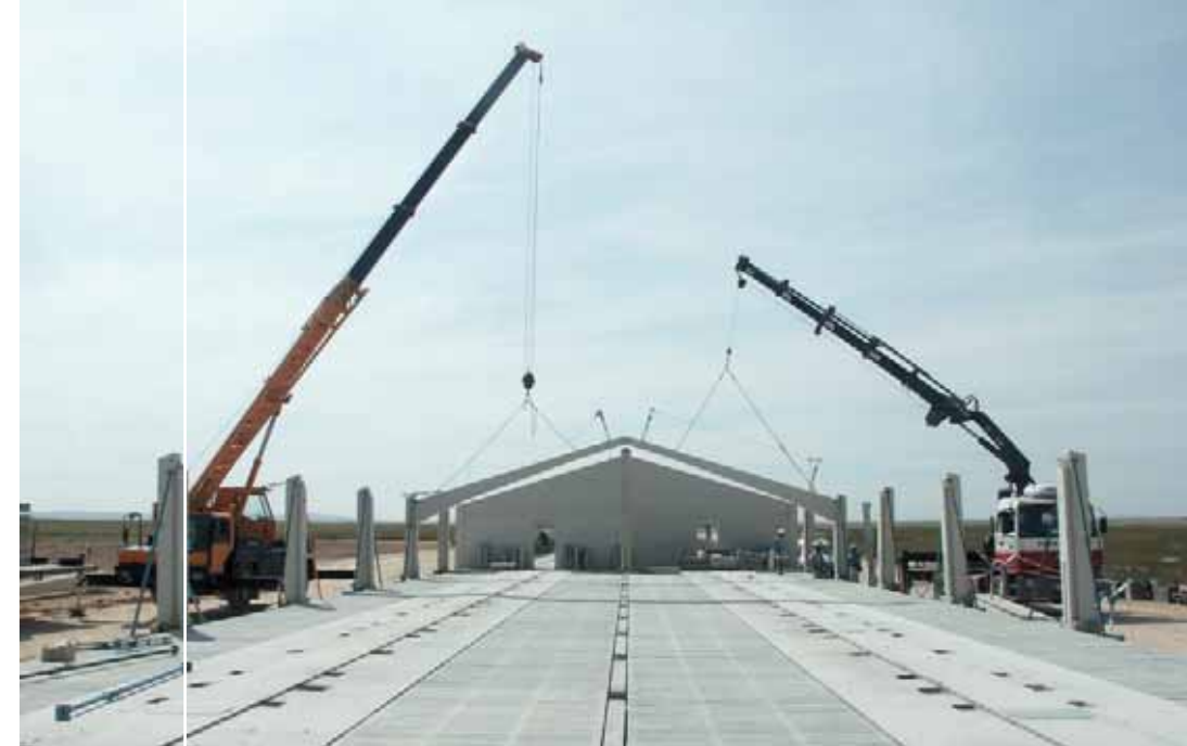
Montaje de Dinteles del Sistema Pórtico
