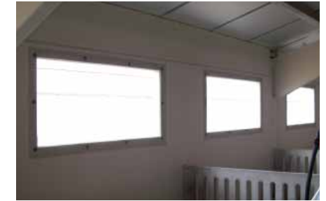
Mosquitera interior en ventanas y sujeción de separadores a cerramiento
