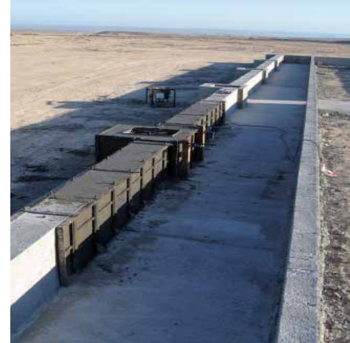
2 | Cimentación de Muros.
